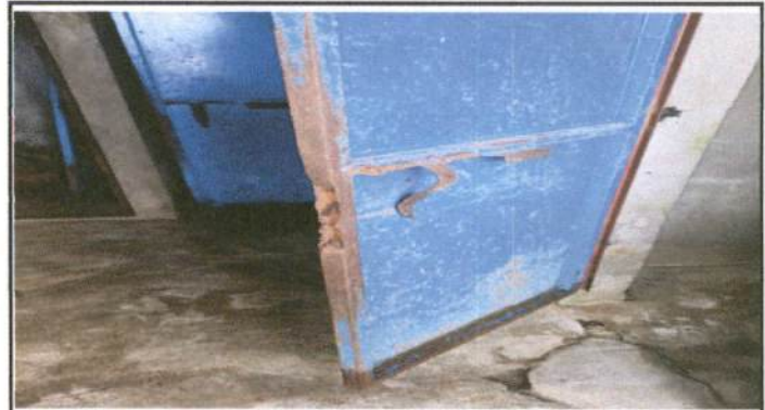
MÓDULO 1 AULAS PUERTAS DE METAL: Mantenimiento a estructura (lijado, cambio de tubo , cepillado, sujeciones, aplicación de pintura); Sustitución de chapa
