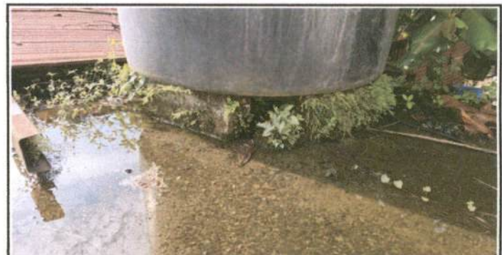
MÓDULOS 2 SERVICIOS SANITARIOS REPARACION Y MANTENIMIENTO DE CISTERNAS / DEPÓSITOS DE AGUA: Sustitución de depósito de agua 1100 lt
