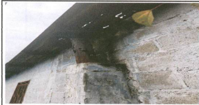
MÓDULO 3 COCINA: CUBIERTA DE LÁMINA: Sustitución de lámina, por lámina troquelada aluzinc calibre 26
