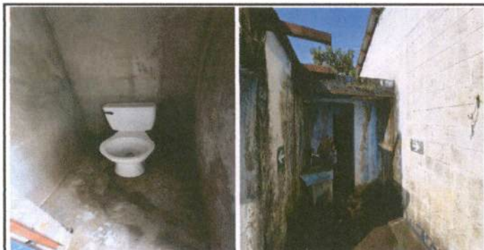
MÓDULO 2 SERVICIOS SANITARIOS: Mantenimiento a estructura (lijado, cambio de tubo , cepillado, sujeciones, aplicación de pintura) a puertas servicios sanitarios
