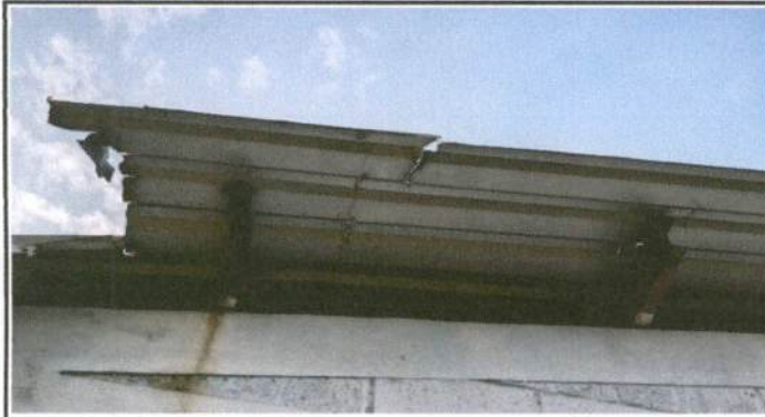
MÓDULO 1 AULAS CUBIERTA DE LÁMINA: Sustitución de lámina, por lámina troquelada aluzinc calibre 26
