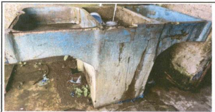
MÓDULO 3 COCINA: REPARACIÓN DE COCINA: Sustitución de pila de cemento de dos lavadero
