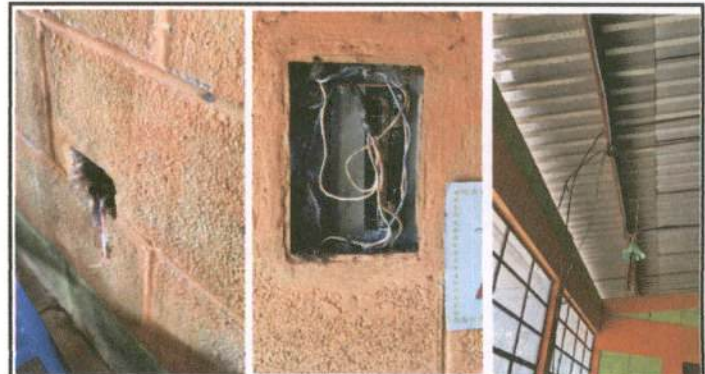
MÓDULO 1 AULAS REPARACION DE SISTEMA ELÉCTRICO: Sustitución de tomacorrientes dobles; Sustitución de tablero de flipones; Reparación de cableado eléctrico
