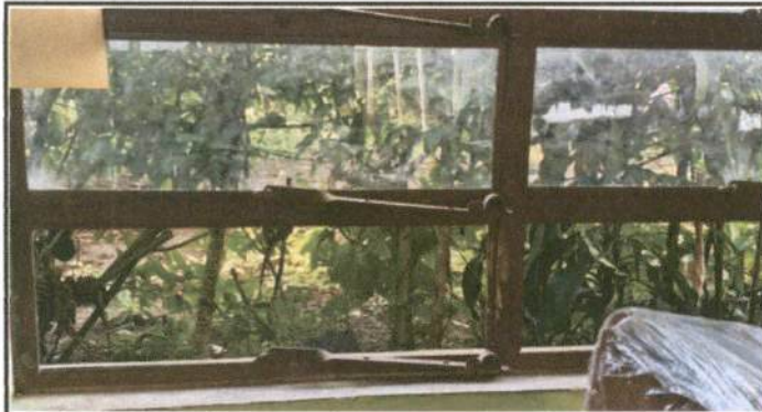
MÓDULO 1 AULAS VENTANAS: Sustitución de vidrios
