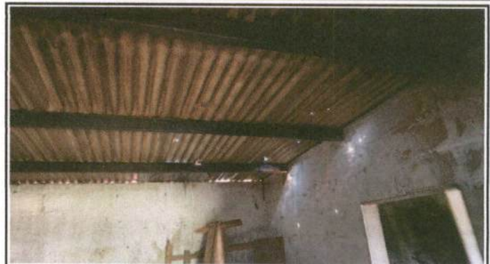
MÓDULO 3 COCINA: ESTRUCTURA DE TECHO: Sustitución de estructura de soporte de metal, por metal
