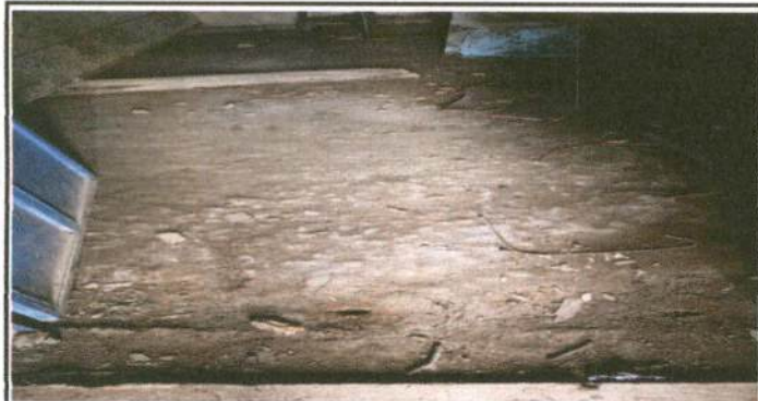
MÓDULO 3 COCINA: PISO: Sustitución de piso de torta de concreto
