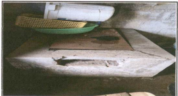
MÓDULO 3 COCINA: REPARACIÓN DE COCINA: Sustitución de estufa rural (completa) incluye chimenea y plancha de metal
